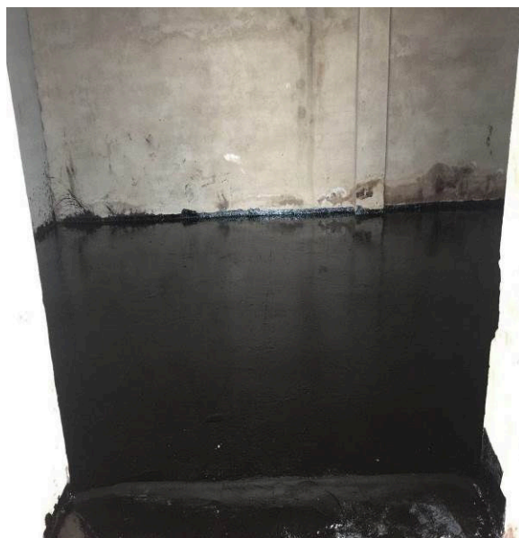
危险废物暂存间图片
